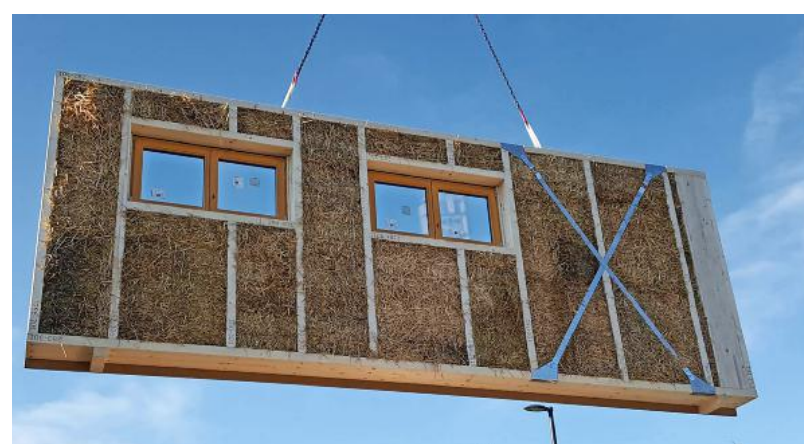
Strohballenhäuser können vor Ort gebaut oder vorgefertigt angeliefert werden. In Deutschland darf das Stroh in Gebäuden meist nicht lasttragend eingesetzt werden.
