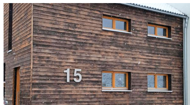
Dieses Strohballenhaus in Mönshheim hat eine Holzfassade. Im Winter muss nicht viel geheizt werden, da Stroh eine besonders gute Dämmwirkung hat.
