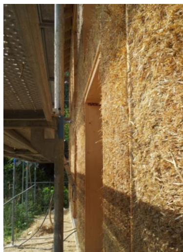
Abbildung 2: Strohwand im eingebauten Zustand
