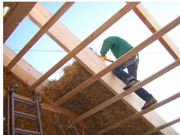
Abb. 6: Strohdämmung zwischen Sparren [© Treibholz Zimmerei, Windeck-Leuscheid]
