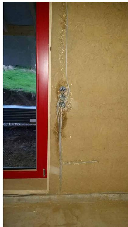
Abb. 11: Elektroinstallation auf dem Grundputz [© Treibholz Zimmerei, Windeck-Leuscheid]
