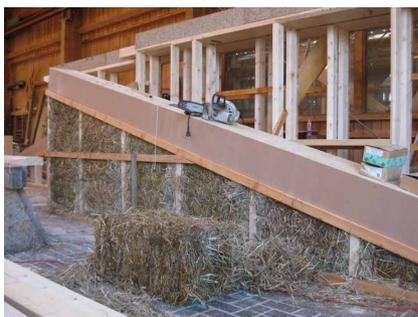
Abb. 4: Vorfertigung Ortgang-Giebel [© Treibholz Zimmerei, Windeck-Leuscheid]
