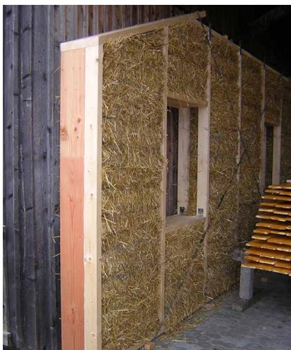
Abb. 2 + 3: Vorfertigung kompletter Wandelemente
