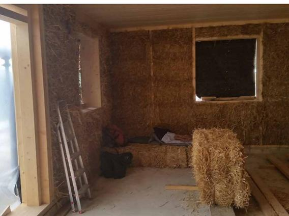
Abb. 9: Strohballenwände und Brettstapeldecke [© Treibholz Zimmerei, Windeck-Leuscheid]
