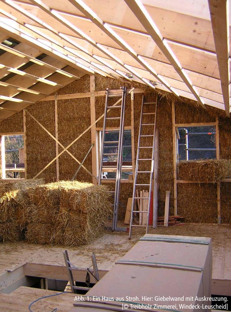
Abb. 1: Ein Haus aus Stroh. Hier: Giebelwand mit Auskreuzung.
