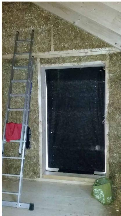
Abb. 5: Giebelwand-Strohausfachung [© Treibholz Zimmerei, Windeck-Leuscheid]
