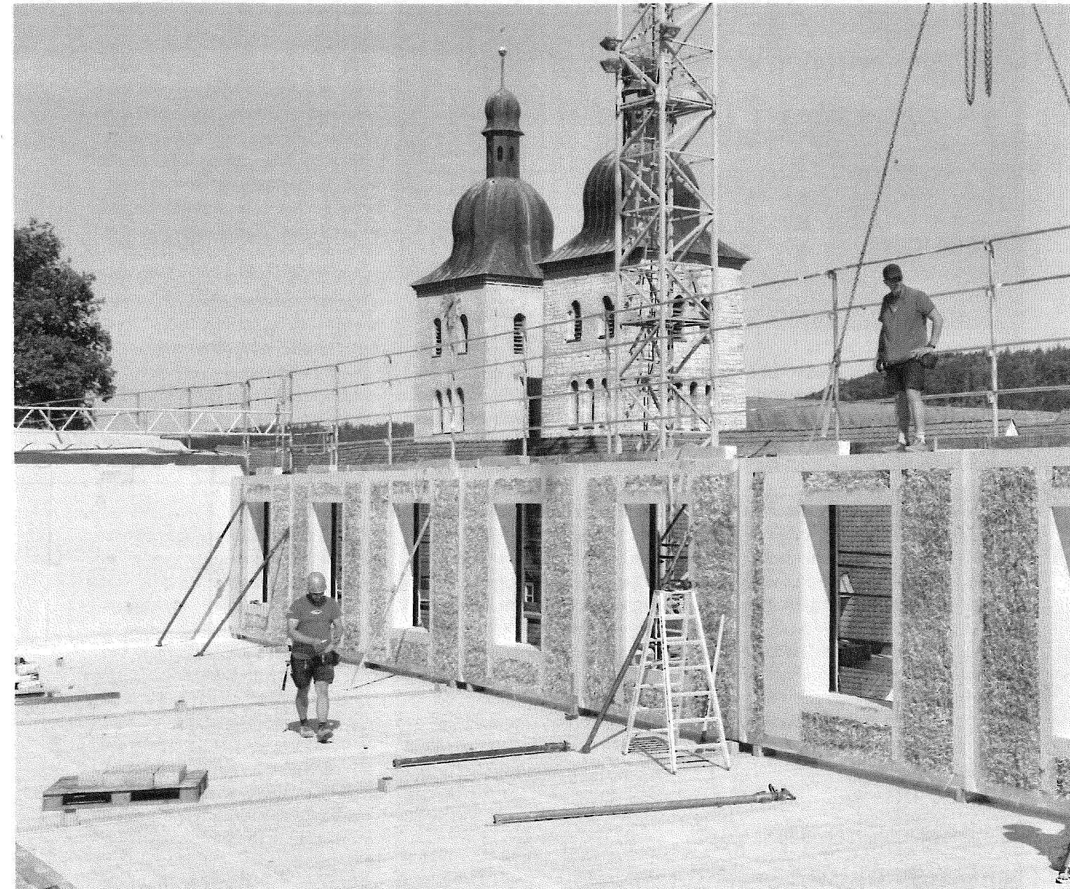
Ein Förderprojekt der EU unterstützte das Bauen mit Stroh in fünf europäischen Ländern, wie hier den Neubau beim Kloster Plankstetten.
