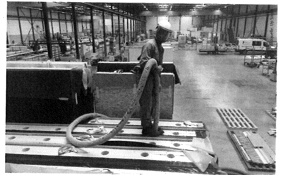
In die Fassadenelemente der niederländischen Sporthalle wurde loses Stroh eingeblasen.
