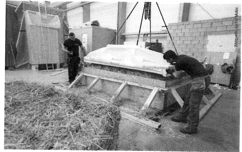
Für das belgische Bürogebäude wurde loses Stroh zwischen die Beplankung aus Holzbohlen gepresst, um die erforderliche Dichte zu erhalten.
