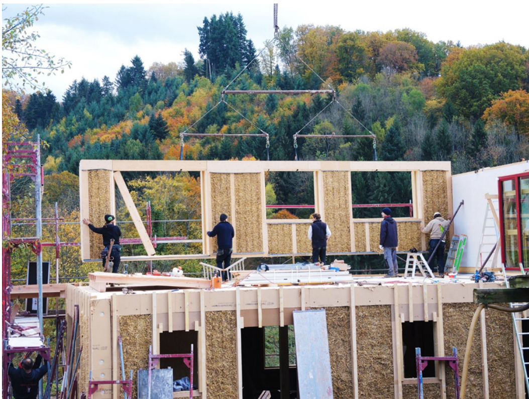
Abbildung 5 Aufstellen eines Strohballenbaus, Zimmerei Grünspecht eG
