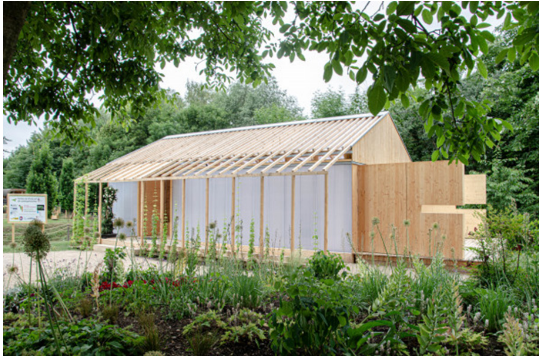
Abbildung 25 Außenansicht ökumenischer Strohbau-Pavillon, PLANWIRK- STATT
