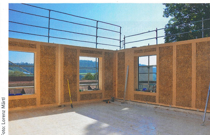
... der Zimmerei Holzbau Bogner insgesamt 2.500 Strohballen gepresst haben.
