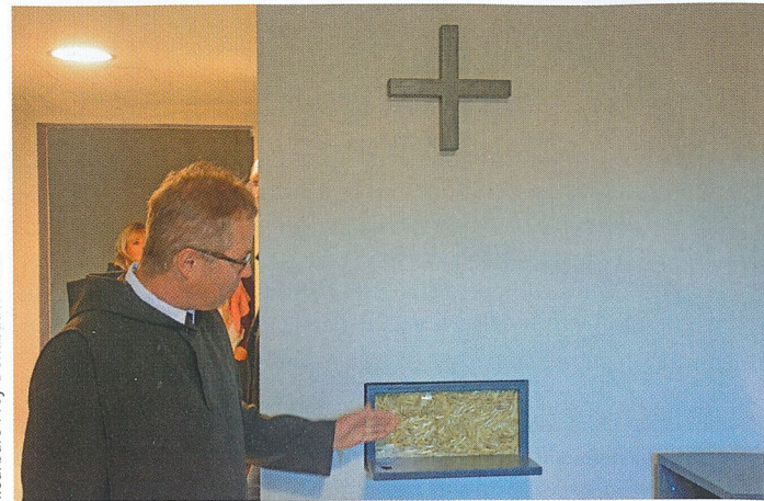
Ein Strohschaufenster zeigt den Aufbau der Wand.
