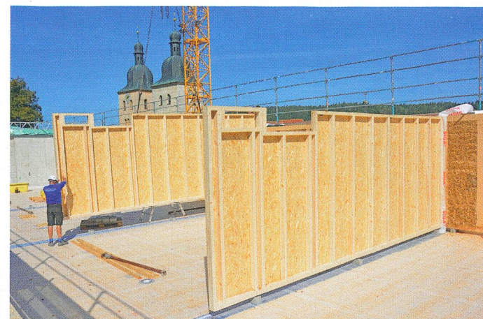
Die Wände bestehen aus Holzrahmen, in die Mitarbeiter ...
