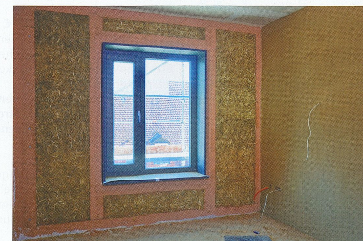
Die fertigen Wände wurden mit Lehm verputzt.
